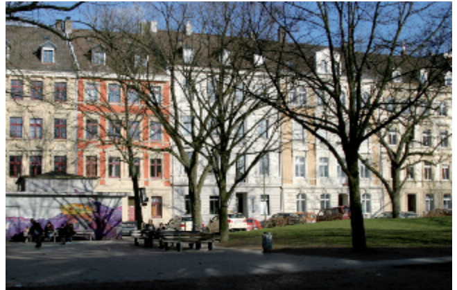
Die Ölberg eG, Wuppertal – Schneiderstraße
