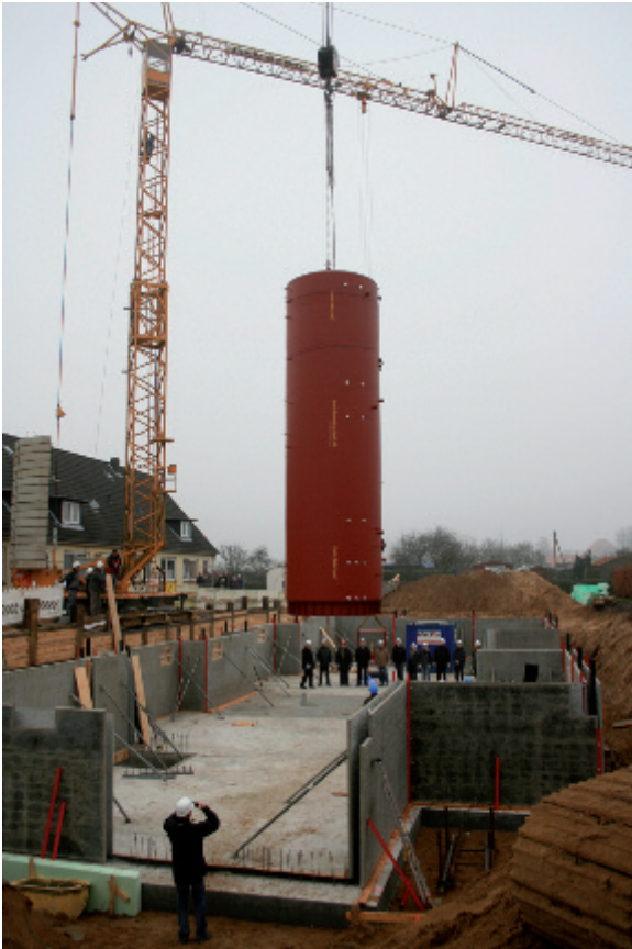
Der Speichertank wird montiert Foto: GEWOBA Nord eG
